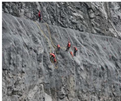
установка систем защиты от камнепада
