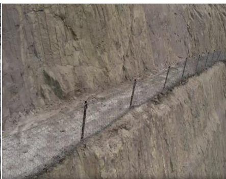
установка систем защиты от камнепада
